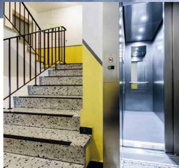
*Blick in die Albrechtstraße 22: Mit dem neuen Aufzug gelangen 33 Mietparteien komfortabel vom Erdgeschoss in das 7. OG. Die alte Anlage war Baujahr 1965, die neue Technik ist dagegen hochmodern und sogar für den Fall eines Stromausfalls gewappnet! Der Aufzug verfügt über ein Sicherheitssystem, sodass bei einer Störung stets die nächstgelegene Etage angefahren werden kann. Dort gehen die Türen auf und Fahrgäste können sicher aussteigen.*
